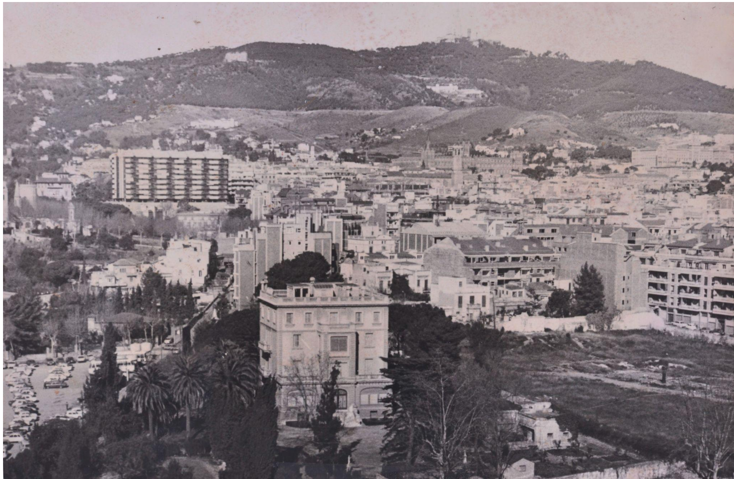
Vista del Casai i el seu entorn cap al 1981. S'estan fent les obres del edificis de l'entorn. © AV de Sarrià
